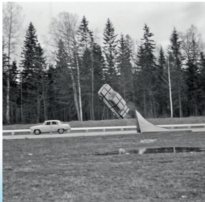
Опрокидывание автомобиля «Запорожец» с помощью трамплина
