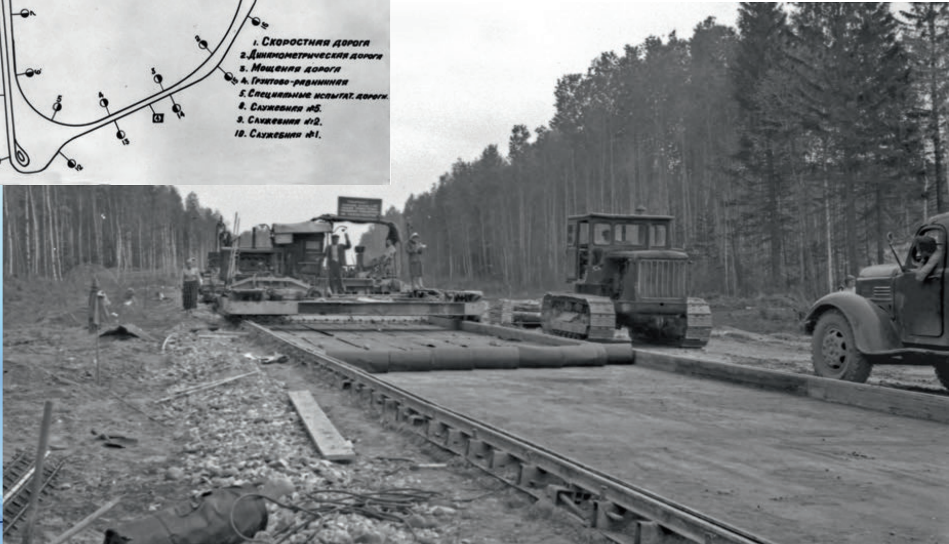
Заливка бетонного основания скоростной кольцевой дороги с помощью специальной техники и опалубки
