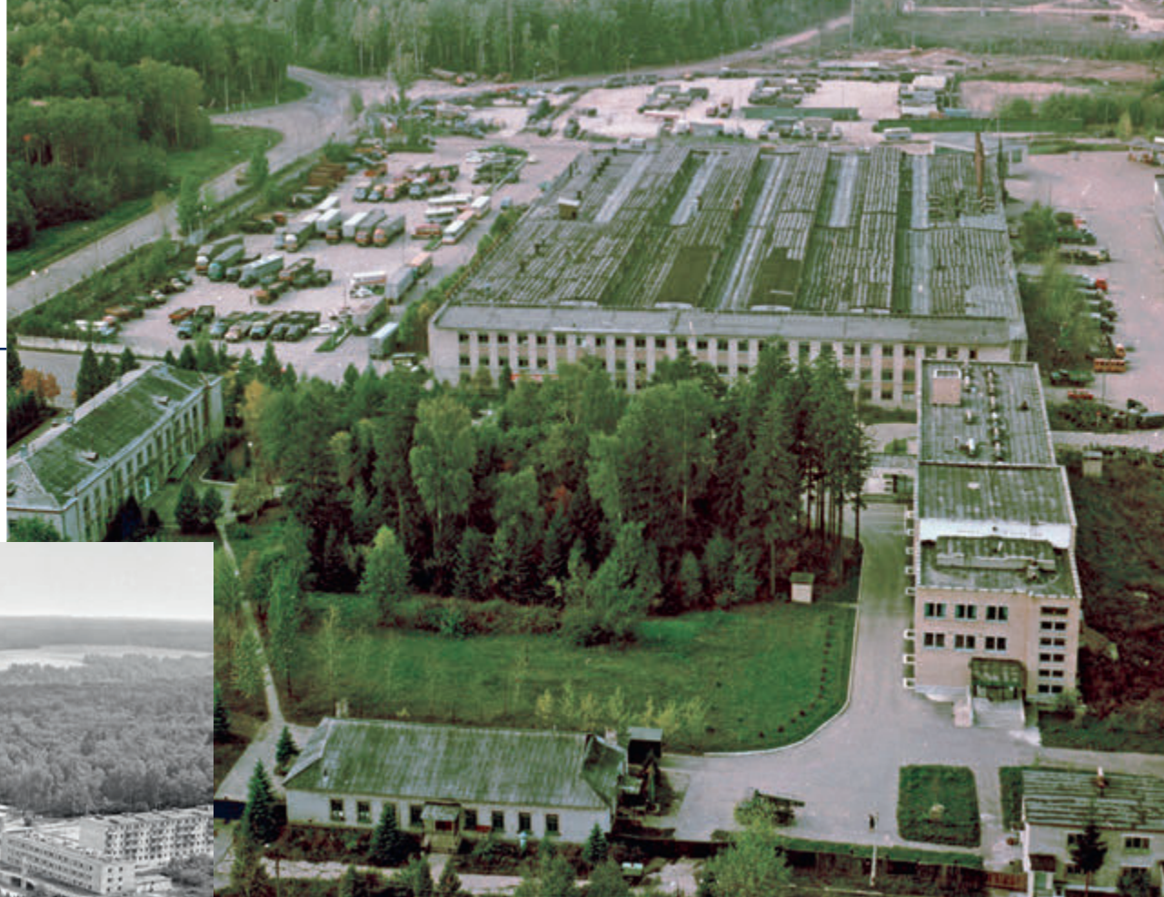
Главный инженерный корпус автополигона и площадка для стоянки техники
