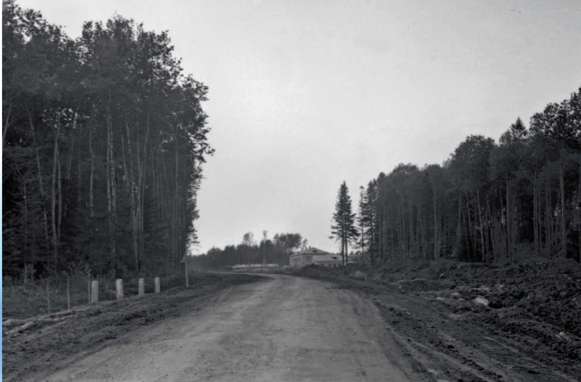
Главный въезд на полигон, проходной и ворот никаких еще нет
