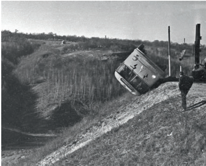
Поперечное опрокидывание автобуса ЛАЗ-695Е
