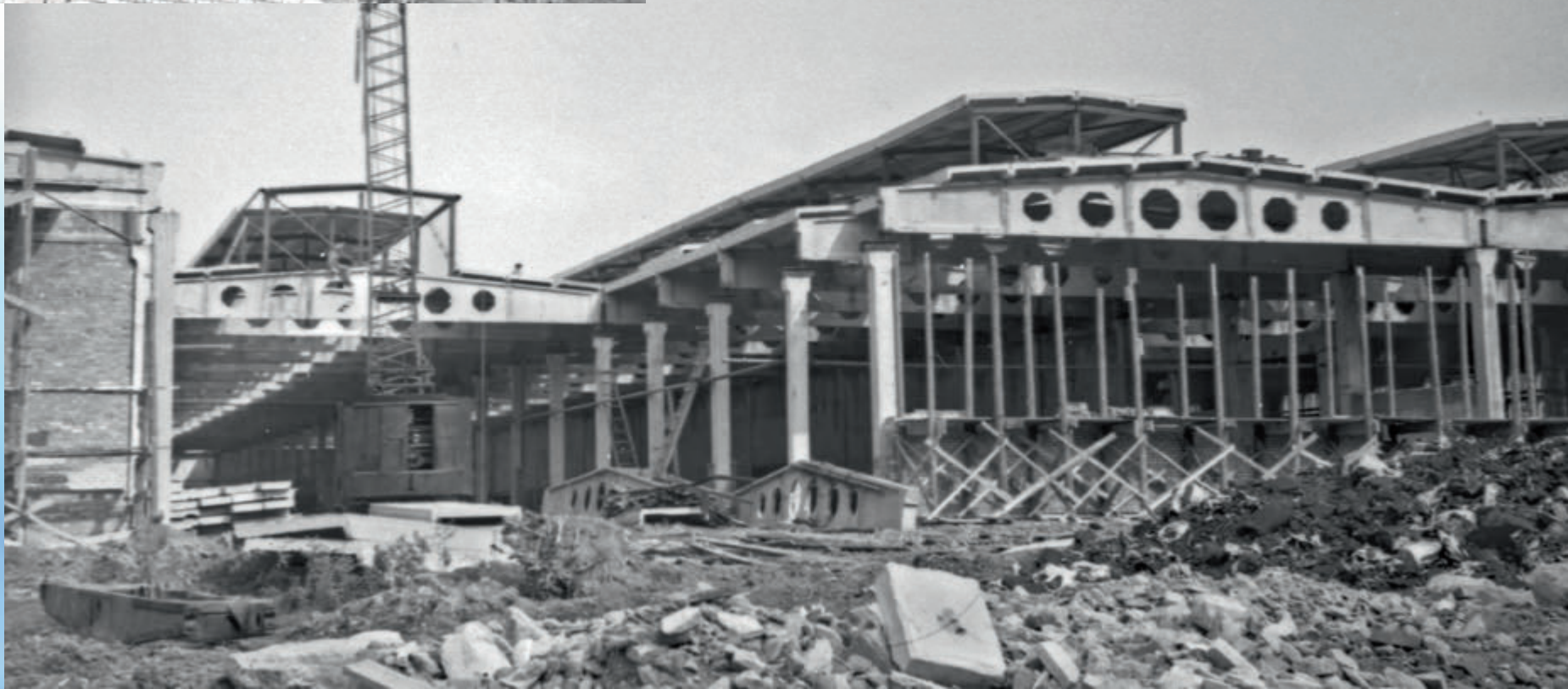
Перекрытие пролетов главного инженерного корпуса
