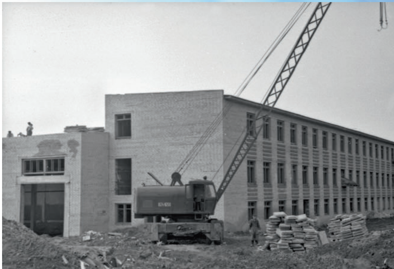
Сооружение главного инженерного корпуса
