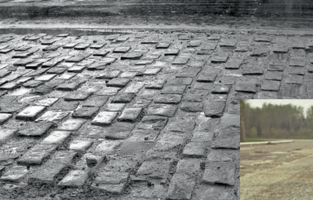
Участок мощения спецдороги «бельгийская мостовая»
