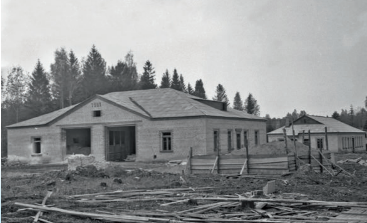
Строительство пожарного гаража
