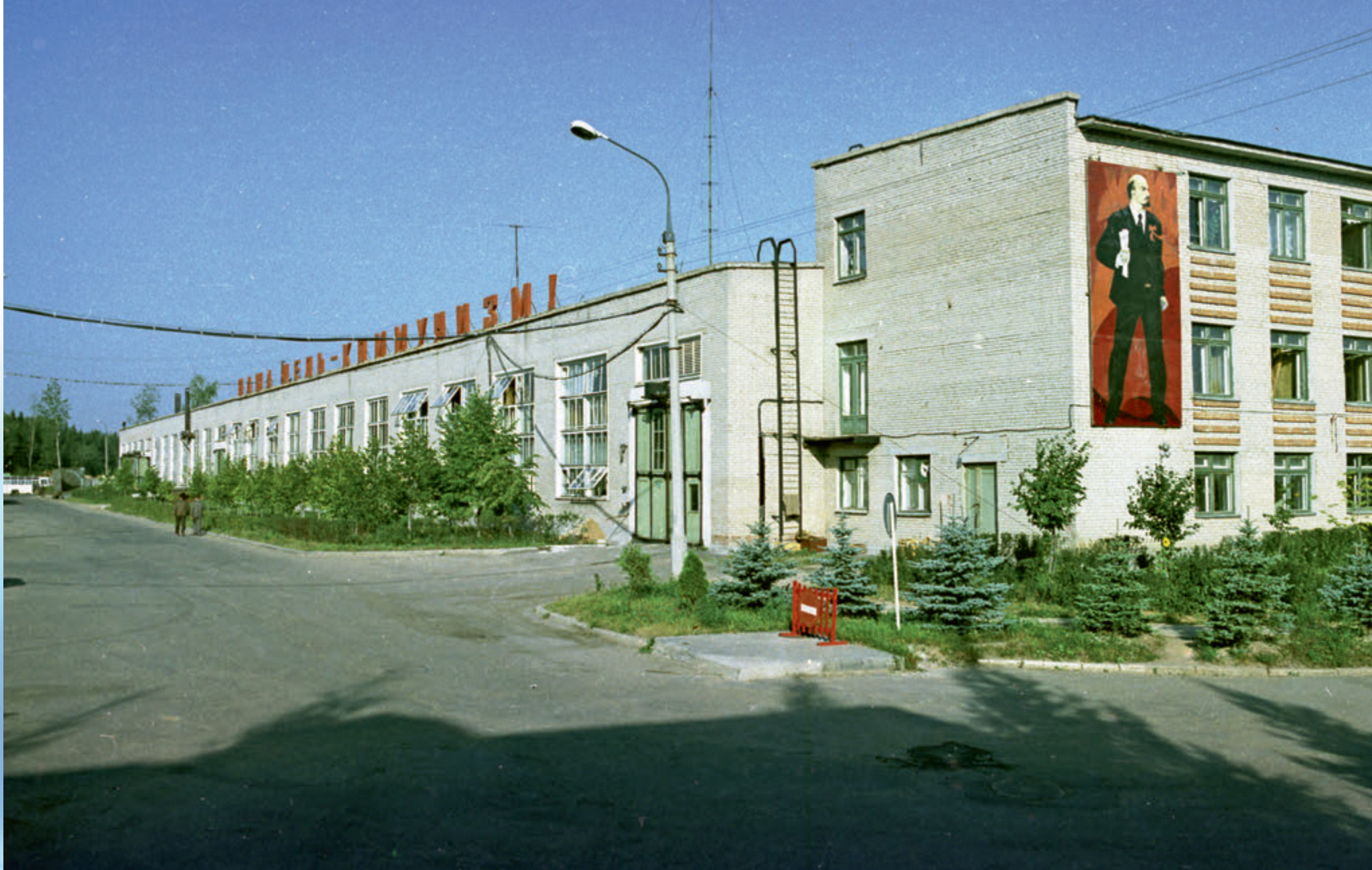
Главный производственный корпус
