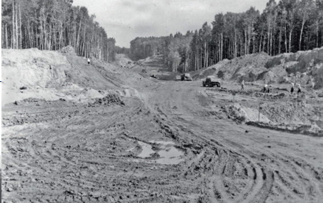
Подготовка трассы будущей кольцевой скоростной дороги
