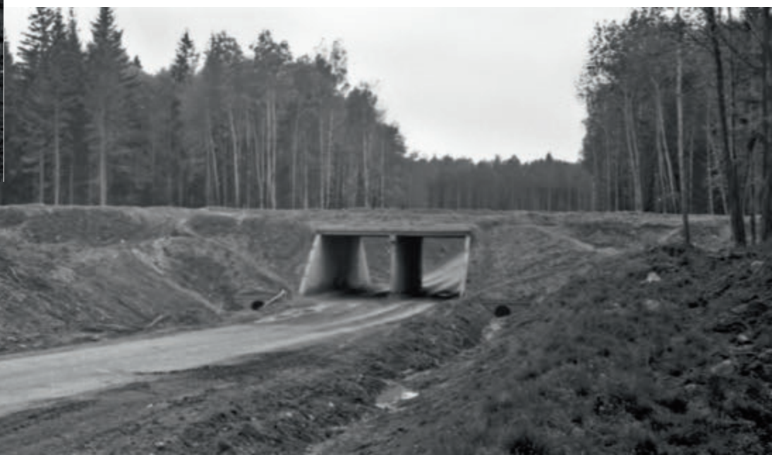
Обустройство кольцевой грунтовой дороги
