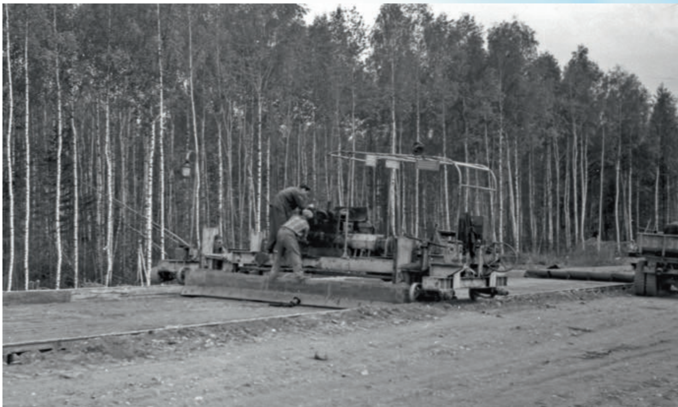
Укладка бетонного основания дорог
