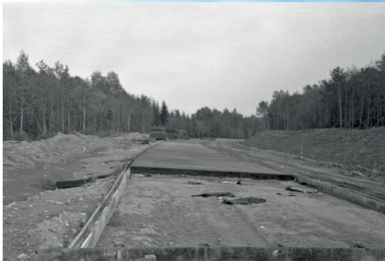
В поворотах профиль скоростного кольца имеет уклон для уменьшения центробежных сил
