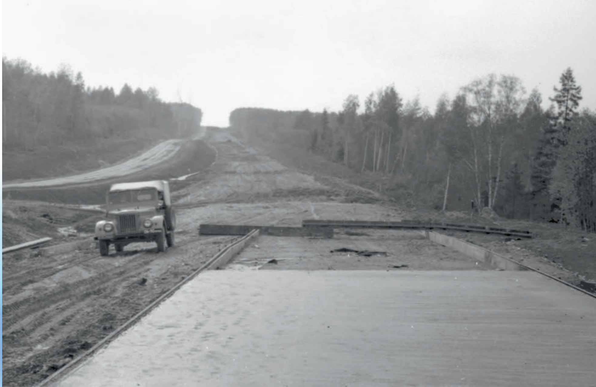
Заливка бетонного основания скоростной кольцевой автодороги
